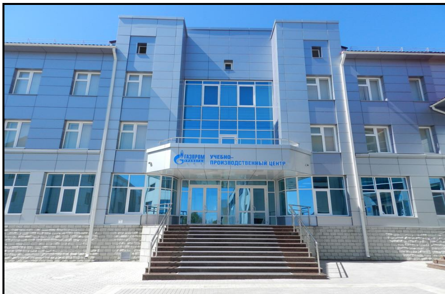
Здание Учебно-производственного центра ООО «Газпром трансгаз Уфа»
