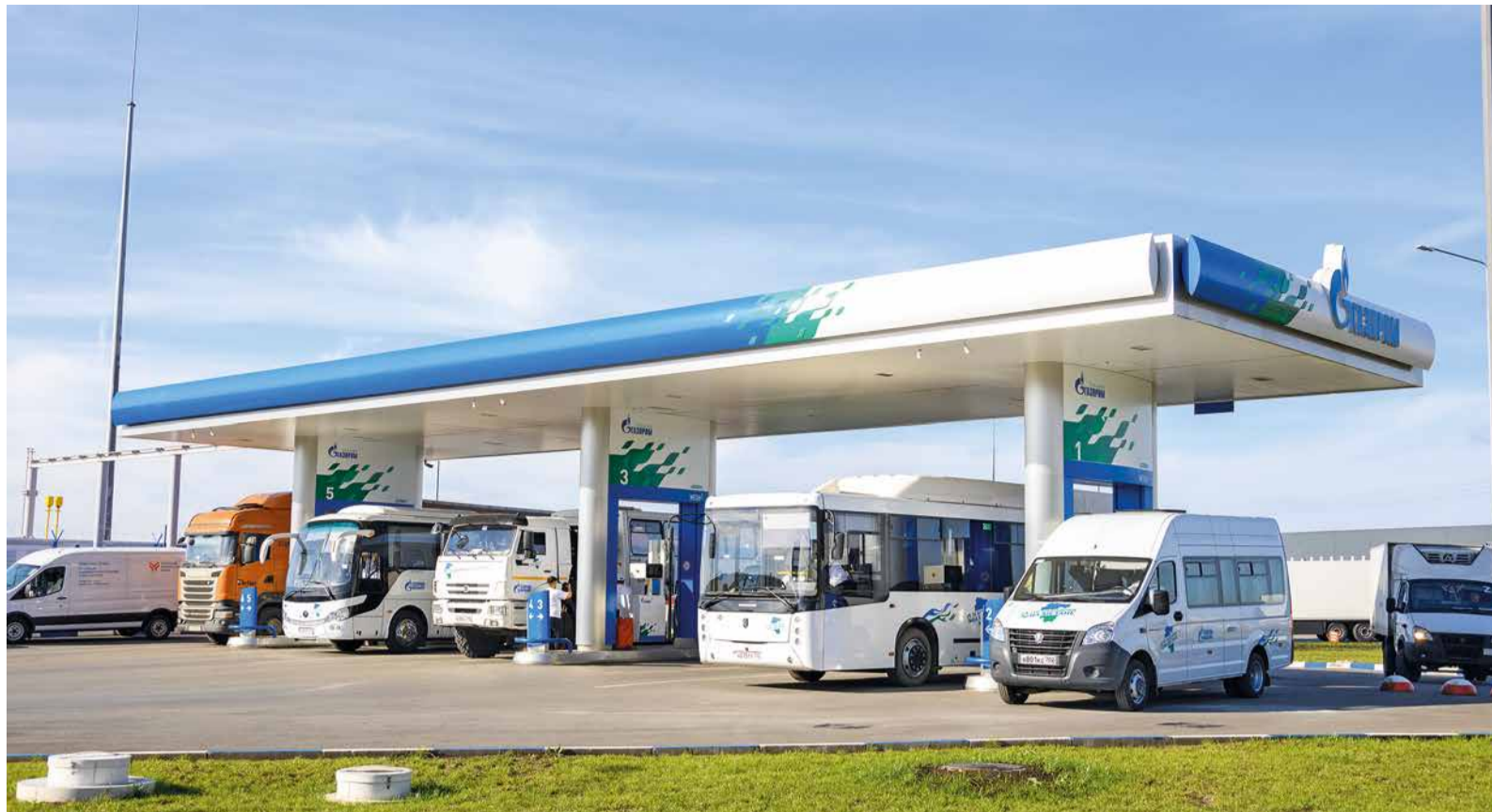
Заправка автомобилей на АГНКС-5 г. Уфы
