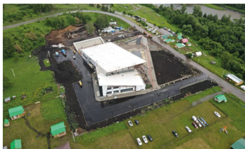
Строящийся музейный комплекс
