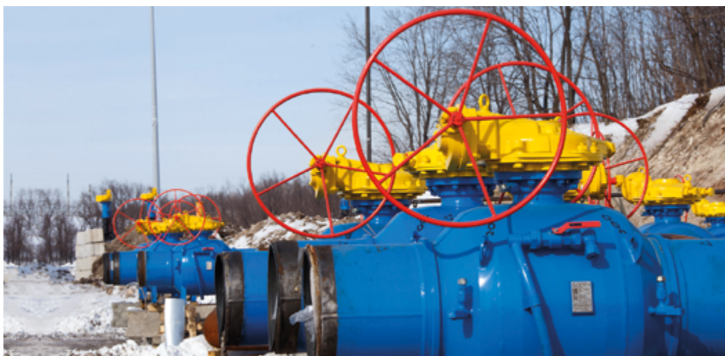
Реконструкция ГРС «Ново-Александровка» проводится согласно инвестиционному проекту ПАО «Газпром»
