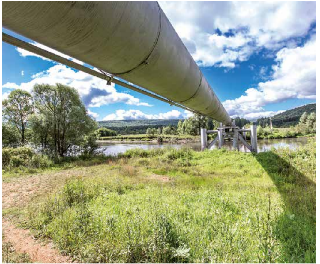
Воздушный переход через реку Юрюзань
