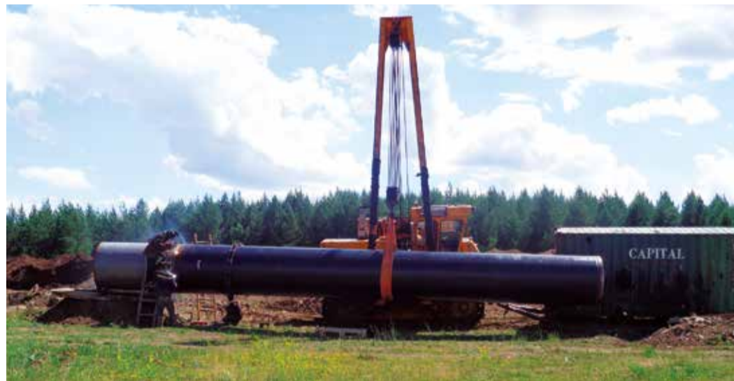
Сварочно-монтажные работы на магистральном газопроводе Уренгой–Петровск
