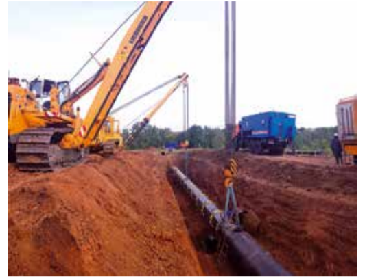
Ремонт на переходе через автодорогу Уфа–Бирск–Янаул
