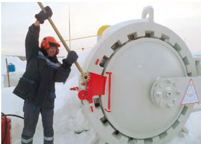
ВТД на участке газопровода Уренгой–Петровск
